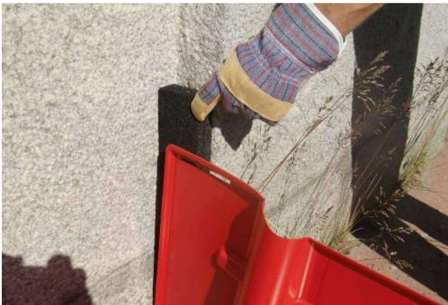
13. Außenverbindung mit Schaumstoff-Streifen abdichten...
