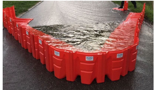
Boxwall als temporäres Rückhaltebecken.
